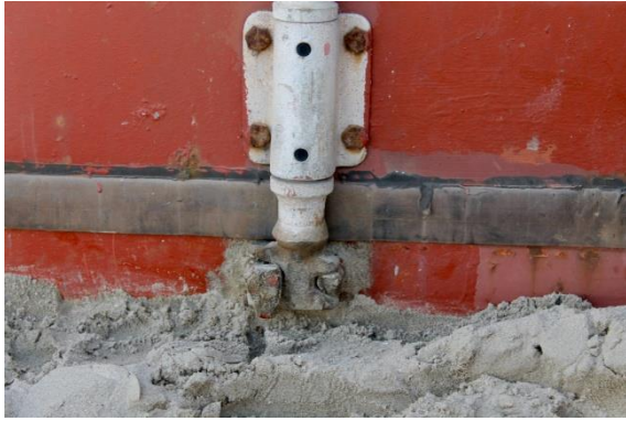
Het sluitingsmechanisme aan de onderkant van de deur
