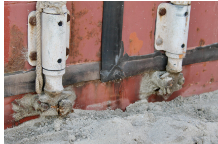
FIGUUR 8.7 Het sluitingsmechanisme zit zowel aan de boven- als onderkant van de deur
