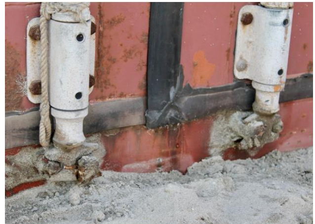
Figuur 8.7 Het sluitingsmechanisme zit zowel aan de boven- als onderkant van de deur
