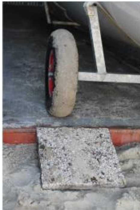
Figuur 6.1 Leg tegels of planken neer in de containeropening zodat de trailer daar overheen naar buiten kan rijden
